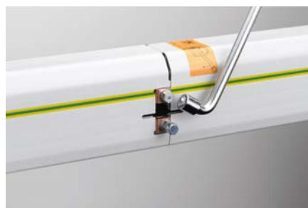
レールジョイント部
