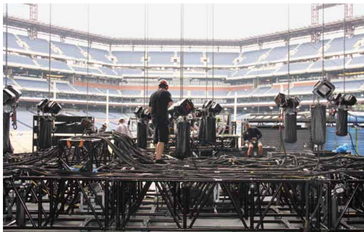
米国の野外コンサート会場。照明や音響装置の設置にたくさんのシアターホイストが使われています。ブラックボディは、ステージの演出を損ないません。
